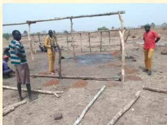
Der Neubau beginnt
