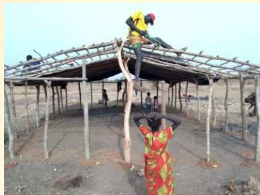
Dachdeckung des neuen Gemeindegebäudes
