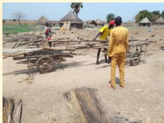
Abbau und Transport des Baumaterials
