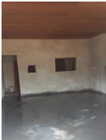
Alle Kachelarbeiten wurden fertiggestellt. Der Estrich wurde in allen Räumen gegossen. Die Holzdecke wurde fertig
